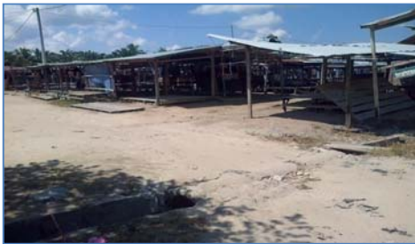
Gambar 3. Kondisi Bangunan Pasar (Survei Lapangan, 2017)
